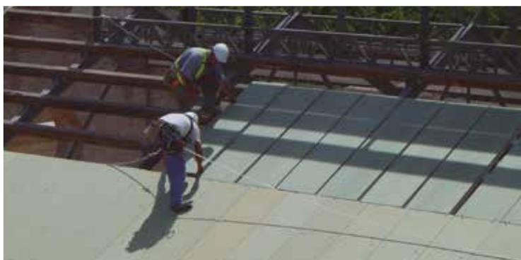
La rapidez y facilidad con la que se coloca el panel sándwich ONDUTHERM, permite, junto con **ahorro en estructura** debido a su ligereza y la **carencia de tiempos de espera**, que este sistema sea económico.
