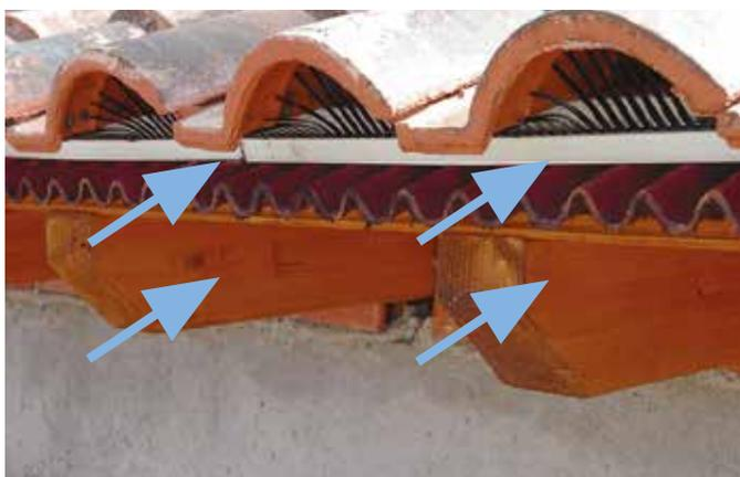
El formato ondulado de las placas Onduline Bajo Teja DRS crea un **doble circuito de aire**, ventilando el soporte de cubierta y evitando la aparición de humedades por condensación.
