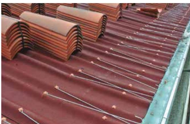
La rugosidad junto con la composición asfáltica y su formato onda-plano proporciona un **agarre natural de las tejas curvas**, reduciendo en gran medida la necesidad de material de agarre.
