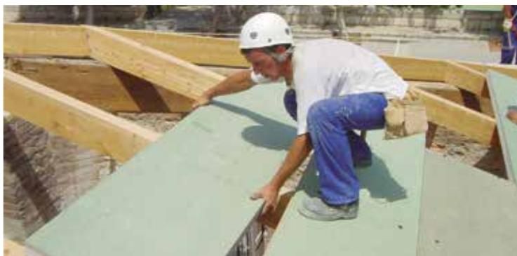
La ligereza del panel sándwich ONDUTHERM, permite trabajar de forma rápida y segura. Además con ONDUTHERM **se evitan** los tiempos de espera por **fraguados y coordinación de gremios**.
