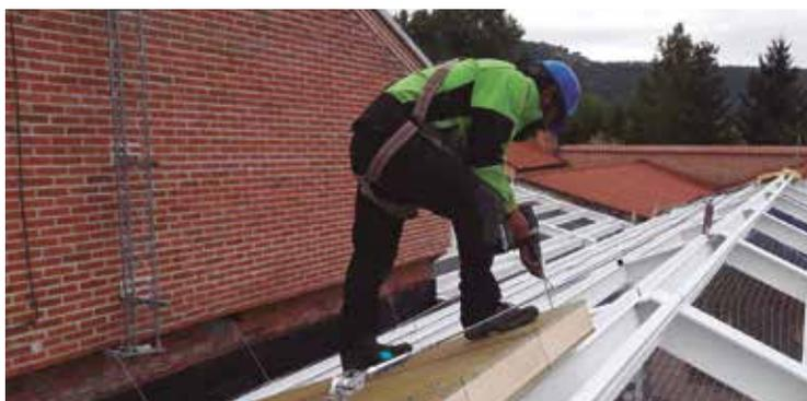
El panel sándwich ONDUTHERM proporciona el aislamiento necesario para tener una **buhardilla confortable**, tanto térmica como acústicamente.
