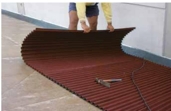
Gracias a su gran flexibilidad y a su fijación mecánica, se **absorben los movimientos** estructurales y las **dilataciones-contracciones**, sin roturas.
